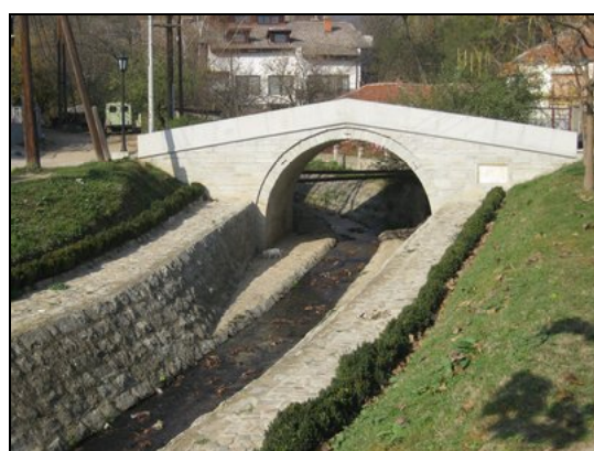
Камени мост - "Бели мост"
